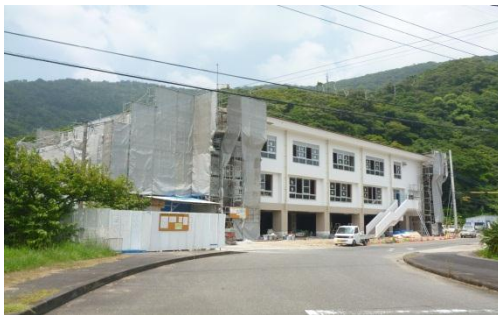
工事中の阿木名小中学校体育館
