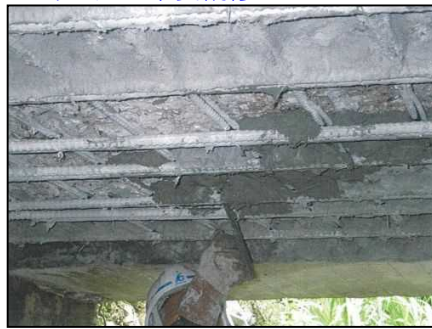
補修状況(断面修復)
