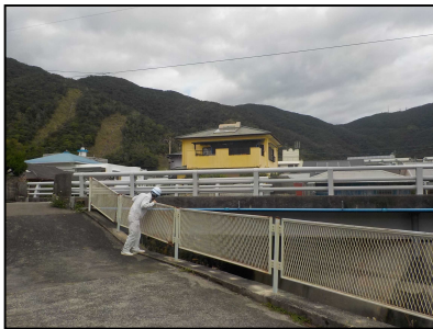
「通常点検」 日常パトロール
