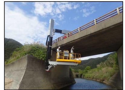
「定期点検 1回/5年」 橋梁点検車点検
