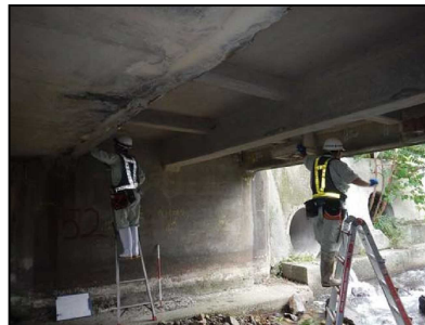
「定期点検 1回/5年」 近接目視による定期点検
