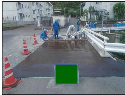
補修状況(舗装打換え)
