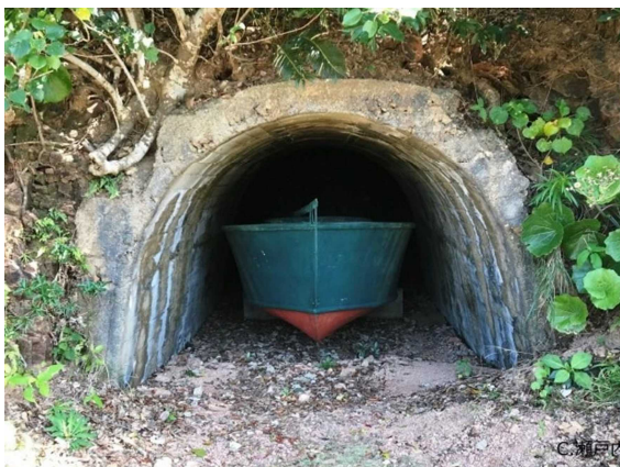
第5格納壕跡（入口）
